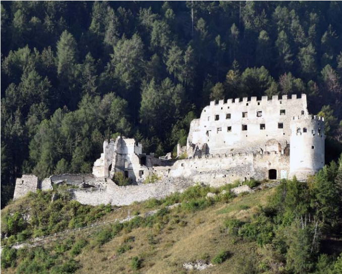
Abb. 4: Hang unter der südlichen Mauer. Alle Fotos: W. Fischer
