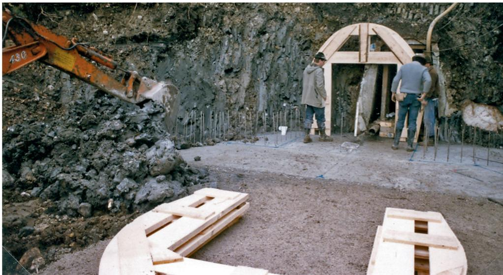
Abb. 7: Kaiserin-Christina-Mundloch: Umbaumaßnahmen in den Jahren 1985/86 mit Verschiebung der Stollenachse zur Vergrößerung des Kurvenradius der Grubenbahn (J. Unterberger).
